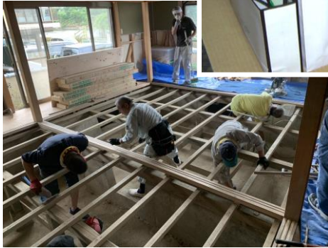
フローリングを 張る前の床下の 清掃作業 (8/26) ←
