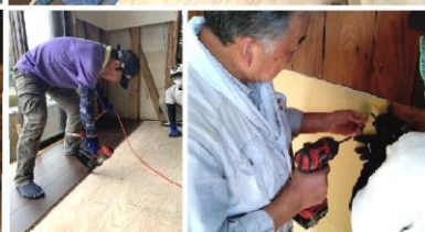
床下の清掃後 フローリング張り とクросの下地の 石膏ボード張りを 皆で作業
